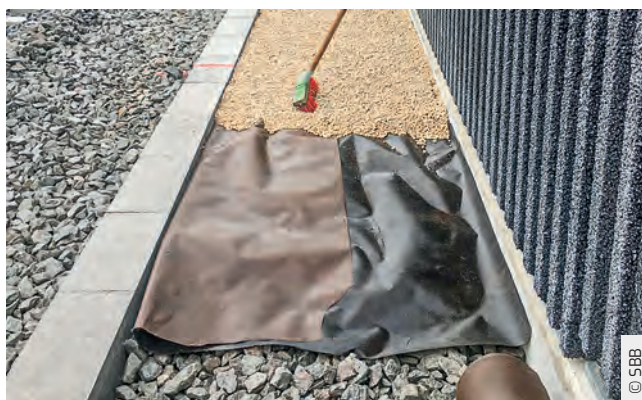
Abb. 34: Einbau einer Folie zwischen Kabelkanal und Lärmschutzwand
