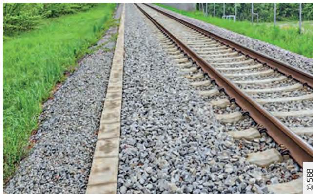
Abb. 33: Ein grobkörnig aufgebautes Bankett bildet gemeinsam mit einem grasbewachsenen und regelmässig gemähten Übergangstreifen eine ideale Vegetationssperre gegen Problem-pflanzen.
