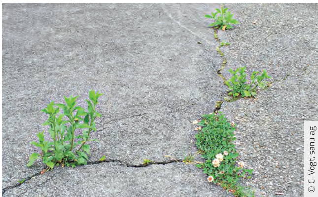
Abb. 27: Belagssanierung als Massnahme gegen unerwünschten Bewuchs
