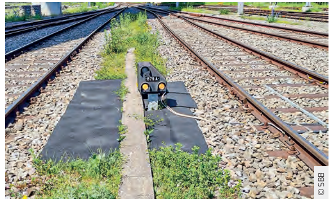
Abb. 35: Gummimatten um Zwergsignal
